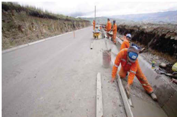
Construcción de la carretera Quinua - San Francisco. Fuente: Serperuano.com
