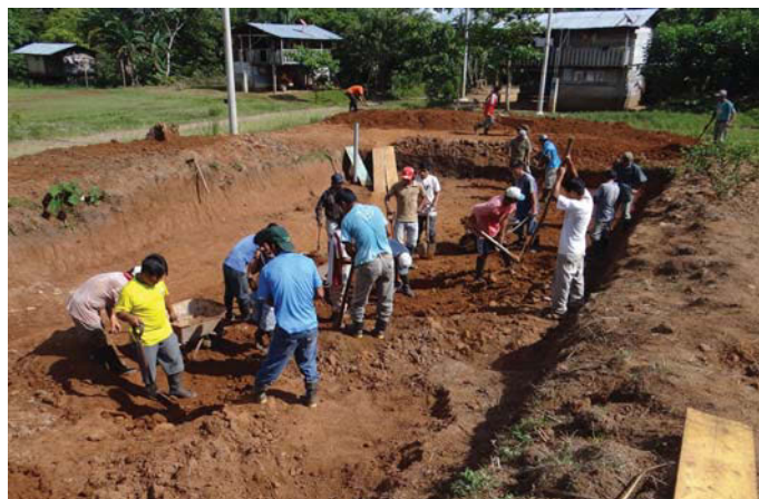
Construcción de piscigranja en cerro azul. Fuente: CORAH
